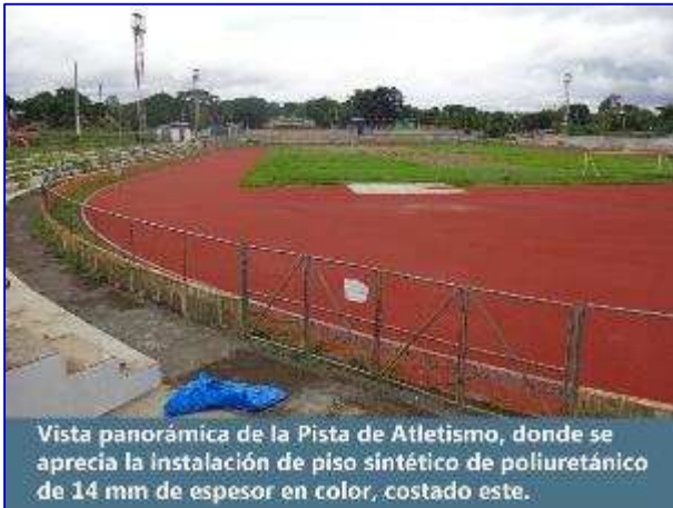
Vista panorámica de la Pista de Atletismo, donde se aprecia la instalación de piso sintético de poliuretánico de 14 mm de espesor en color, costado oeste.
